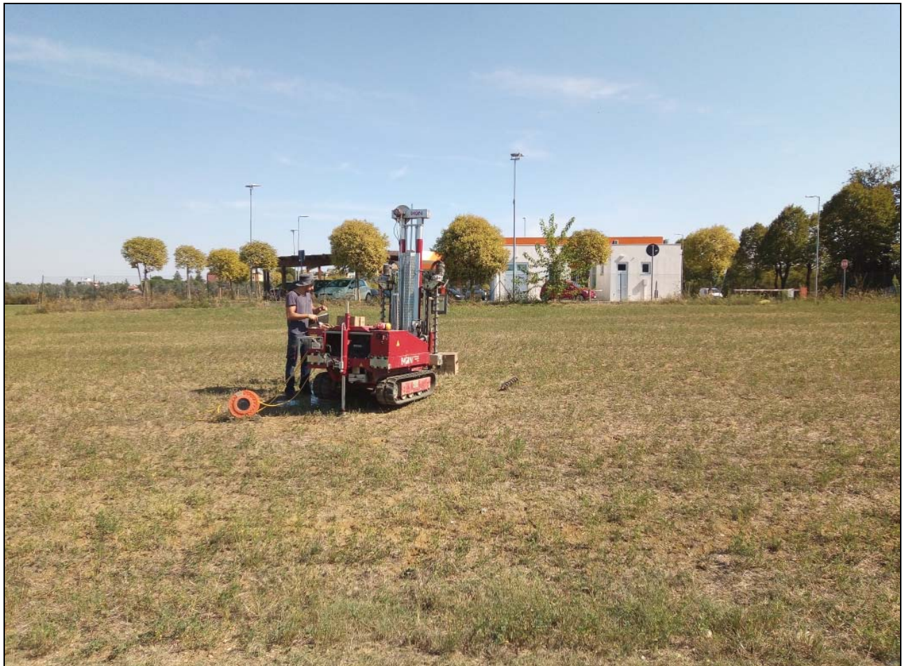
Foto 2 – Punto di esecuzione penetrometria CPT2
