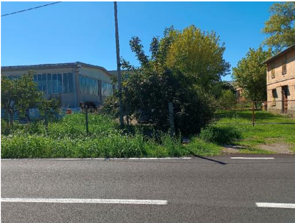
10. Vista del punto di ingresso della tubazione DN 80 cm da area artigianale Colombarotto. A sinistra stabilimento Naldi
