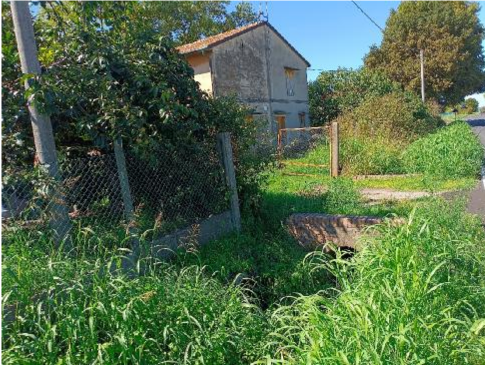
9. Vista passo carraio in prossimità del civico 12. In prossimità del ponte si ha l'ingresso dall'area artigianale Colombarotto
