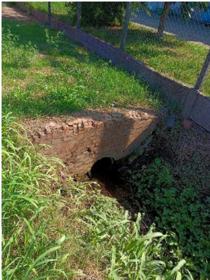
6. Inizio tombamento fosso Bicocca tra via Colombarotto e Via Selice. Tubazione in cemento diam 40 cm
