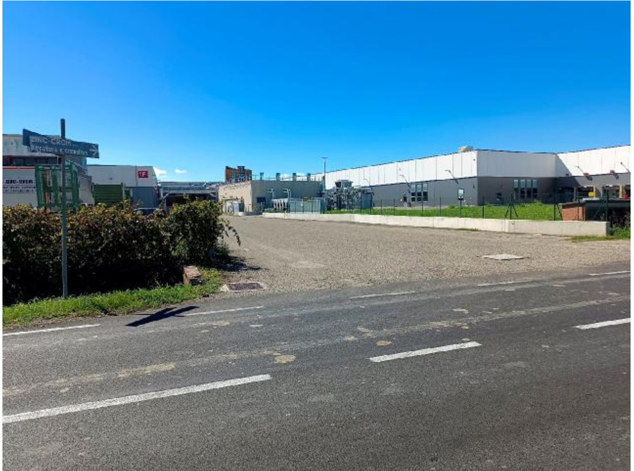
11. Passo carraio accesso area artigianale. Il tombamento a cura Terremerse termina indicativamente in questo punto.
