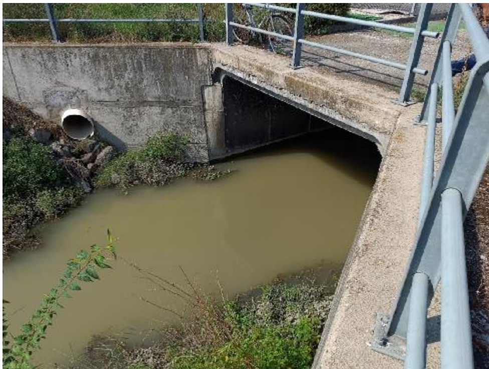
2. Canale dei molini su Via Selice a Nord dell'incrocio con Via Bicocca in corrispondenza all'inizio dello scatolare di tombamento. Si noti lo scarico stimato DN80 cm
